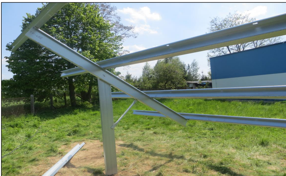
Fot. 3. Montaż konstrukcji stalowej
