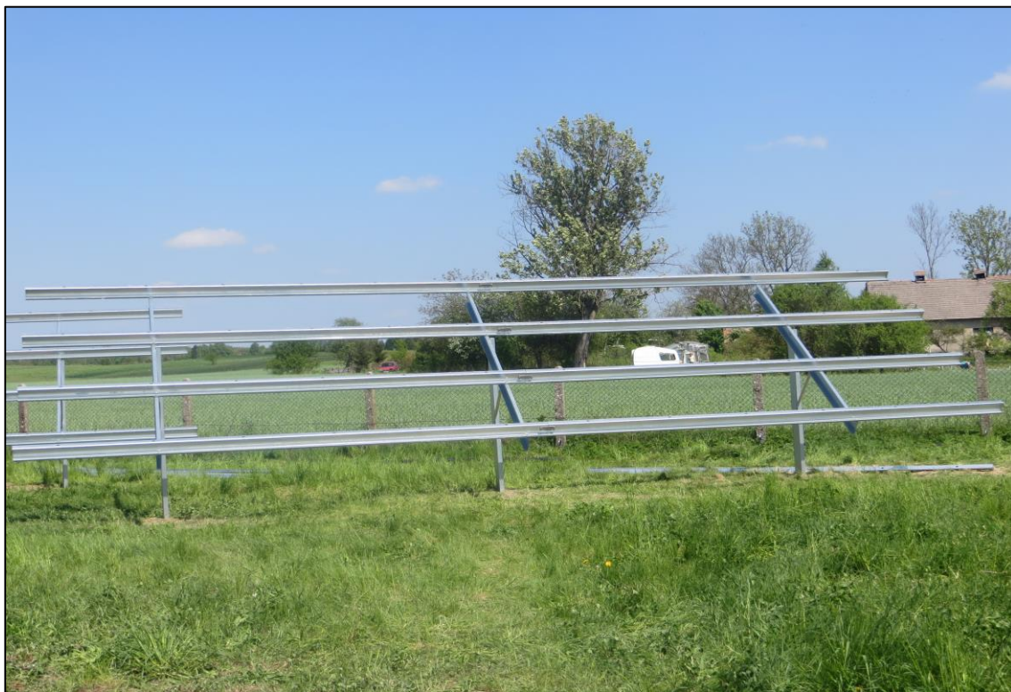
Fot. 4. Montaż konstrukcji stalowej
