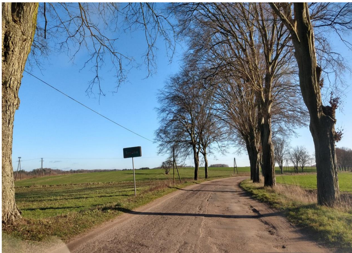
Początkowy odcinek drogi planowanej do przebudowy, w miejscowości Trudna, widok w kierunku wschodnim.
