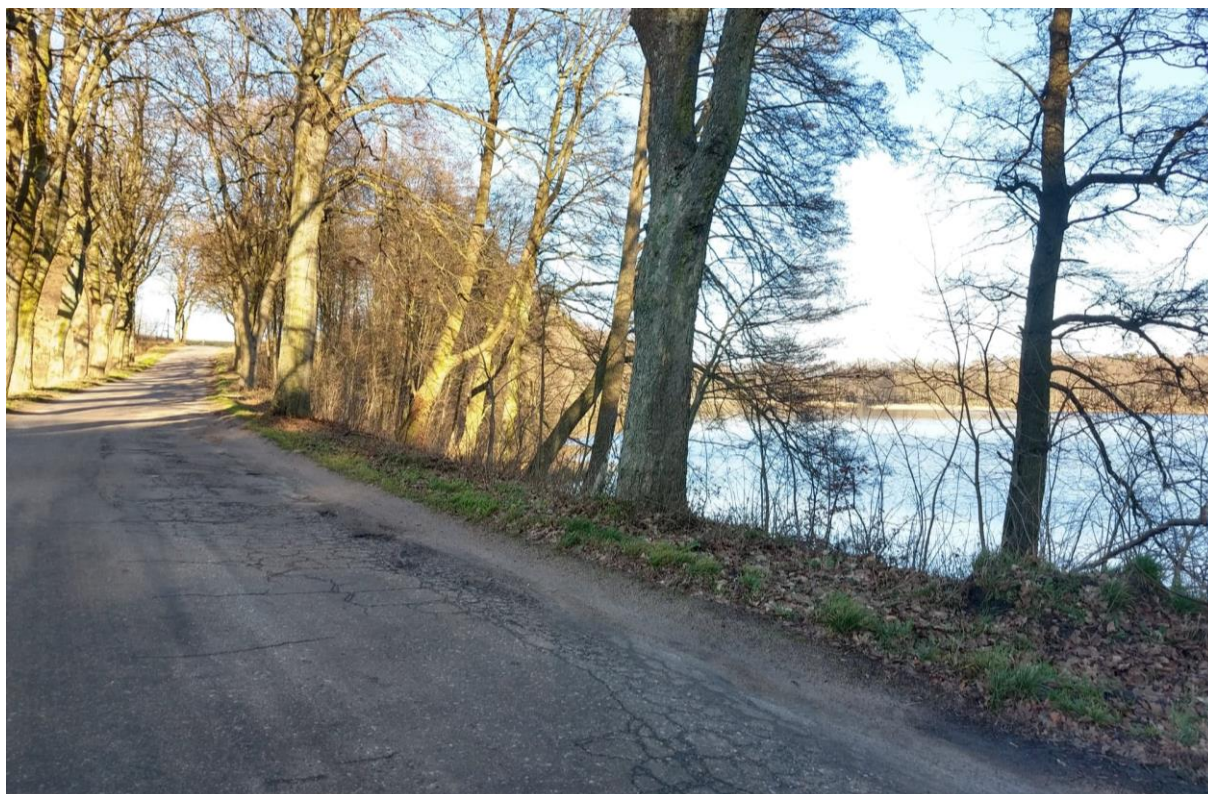
Fragment drogi przebiegający przy Jeziorze Łąkie, widok w kierunku północnym.
