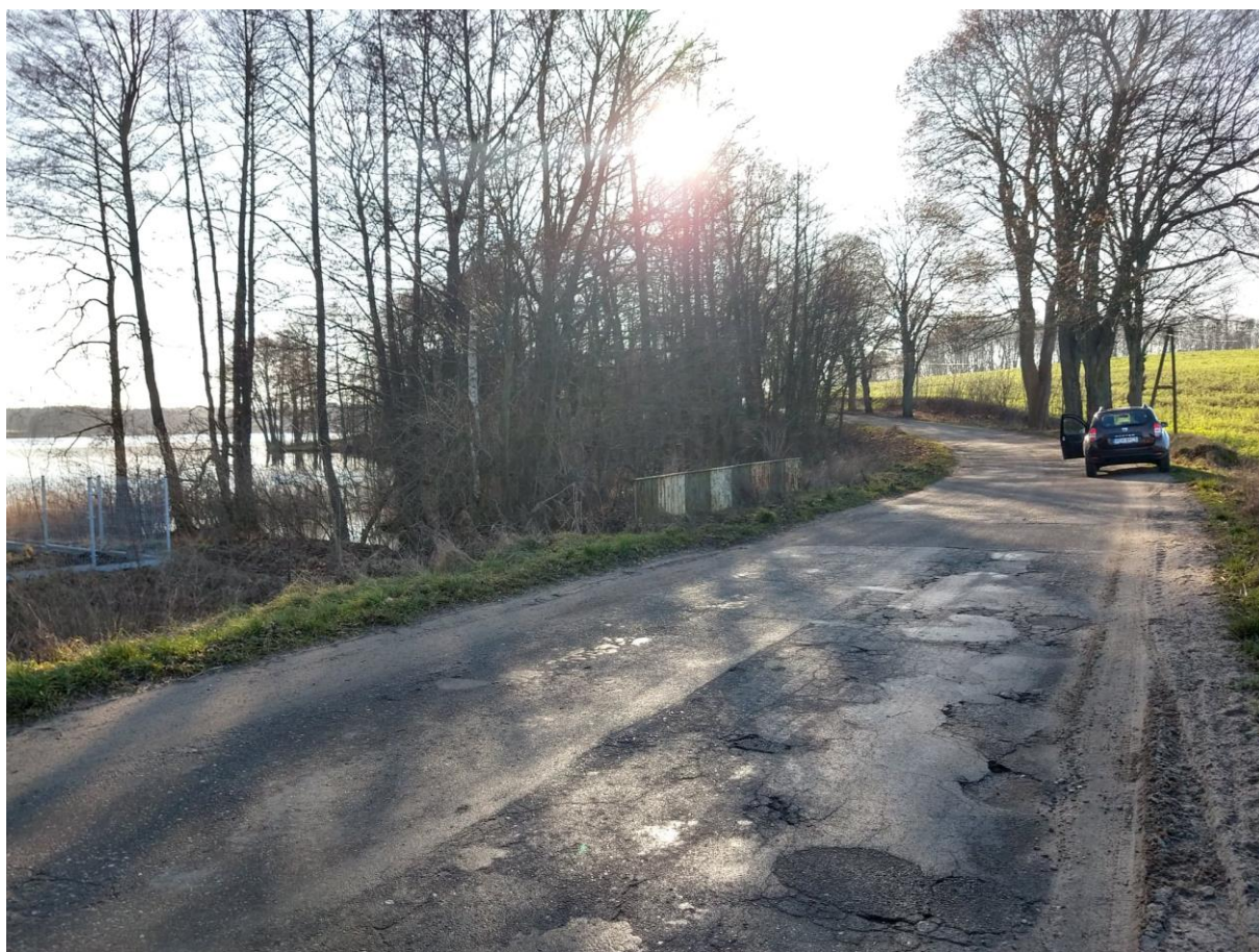
Przepust drogowy na cieku wypływającym z Jeziora Łąkie, widok w kierunku północnym.
